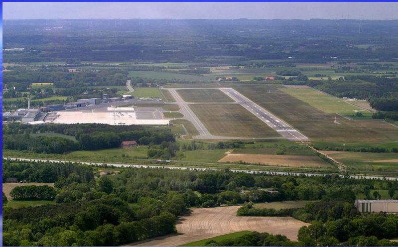
Vermessungsarbeiten Sanierung der S/L Bahn am Flughafen Münster/Osnabrück
